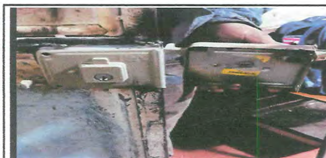
Foto 5: instalación de chapas
