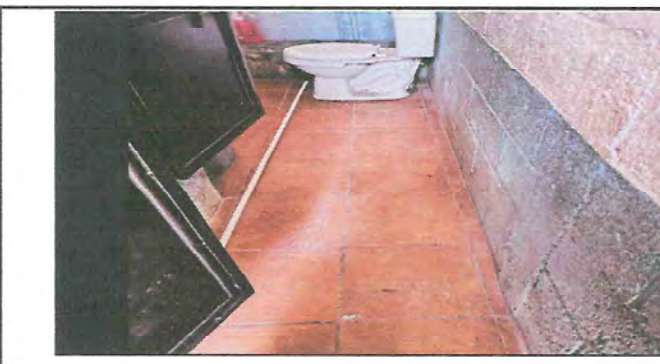
Foto 4: instalación de piso
