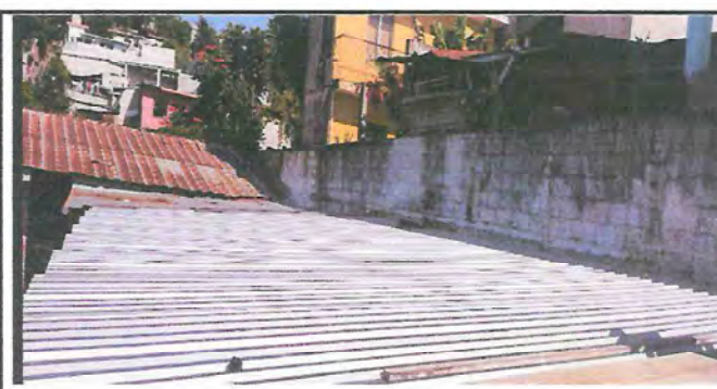
Foto 6: instalada lamina troquelada
