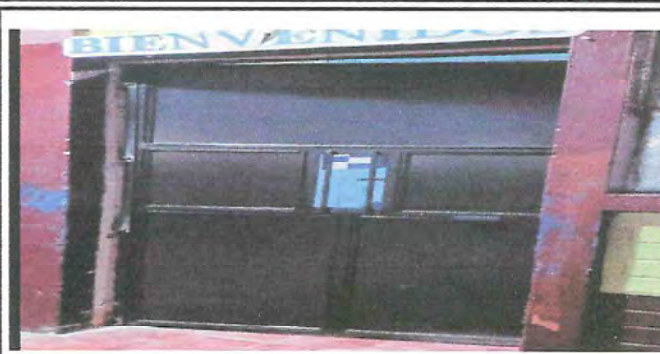
Foto 2: puertas de baños y salón
